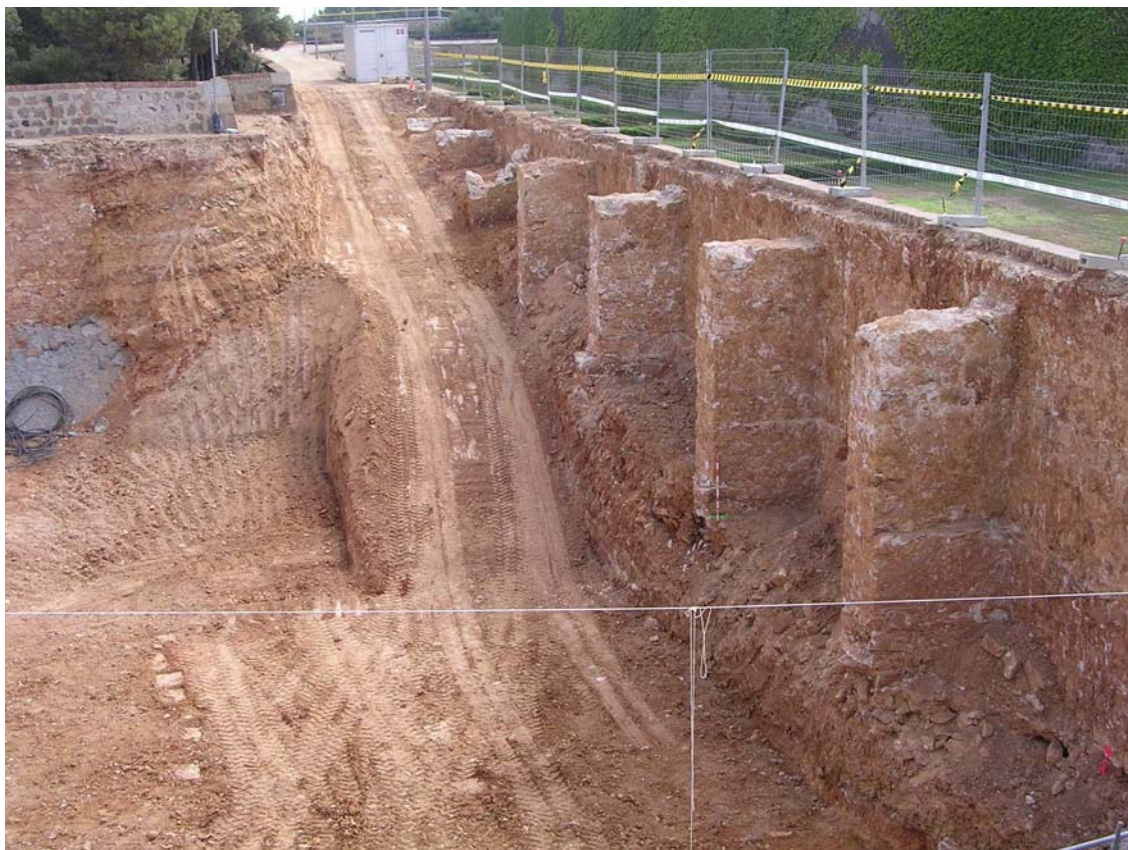
Vista general dels contraforts o estreps, apareguts en el marc de la intervenció i que reforcen internament la contraescarpa del fossat i que delimiten interiorment el camí cobert de Montjuïc (Foto Daniel Alcubierre)
