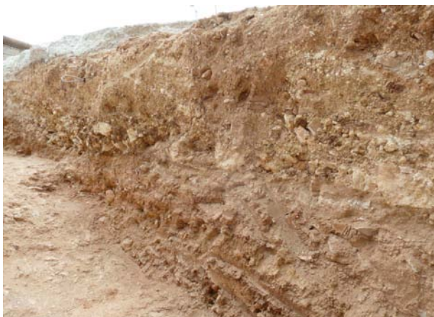
Vista del rebliment de la zona de la porta. S'observa l'absència de nivells d'enderroc amb blocs de pedra.
