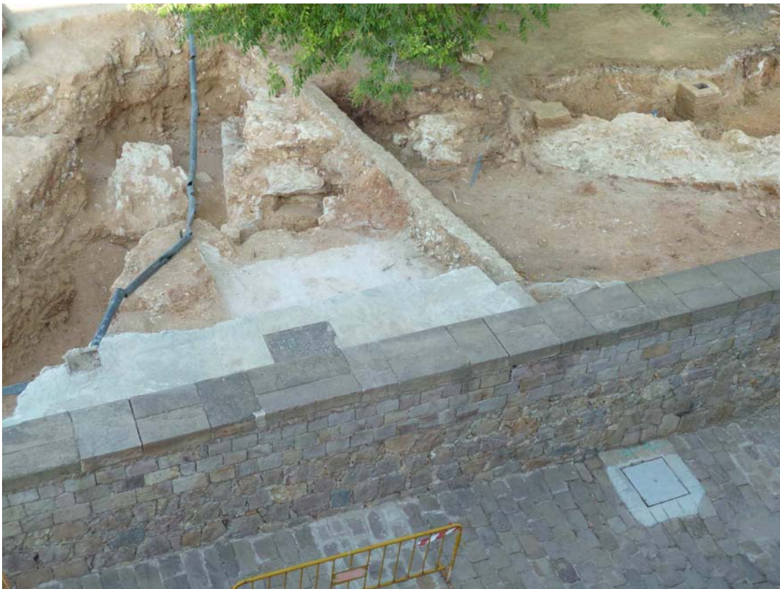
Vista general de la posició de la porta i del mur del camí cobert
