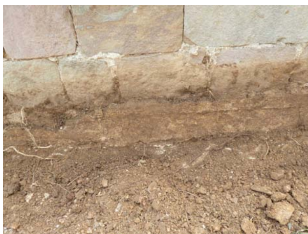
Detall de l'arrebossat de guix associat a l'ús de la barana del semibaluard com a paret de l'antic barracó militar
